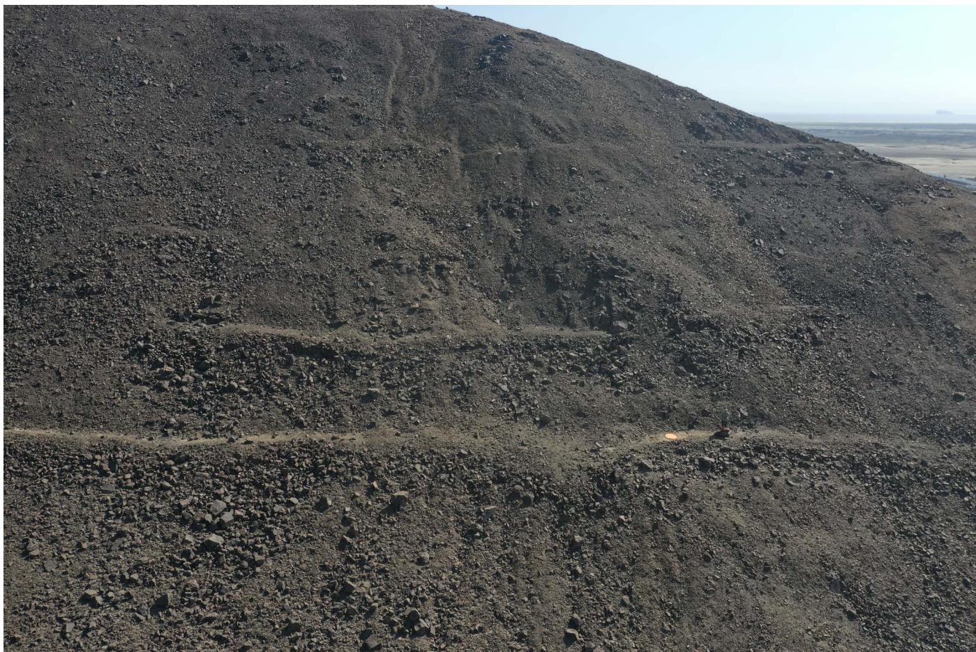
Fotografía aérea del cerro Costomba donde se muestra el aterrazamiento del cerro para disminuir el impacto de posibles derrumbes causados por fuertes lluvias de El Niño (fotografía: Archivo PRAET).
